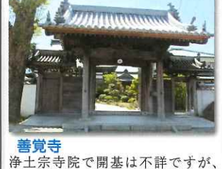
善覚寺 浄土宗寺院で開基は不詳ですが、元は内陸の小海にあったと伝えられています。寺の門は、引田城の門を移築したと伝わっています。
